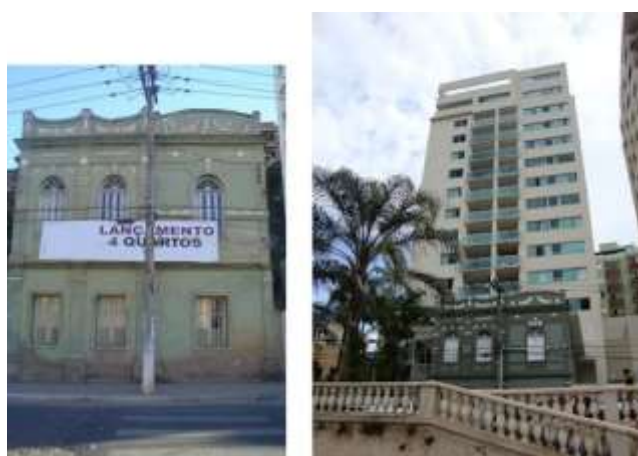
Figura 2 - Casa Cora Bolívar (a) e Edifício Cora Bolívar (b).
