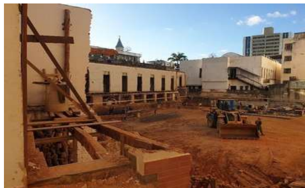
Figura 7 - Demolição do Hotel Rubim (março de 2022).
