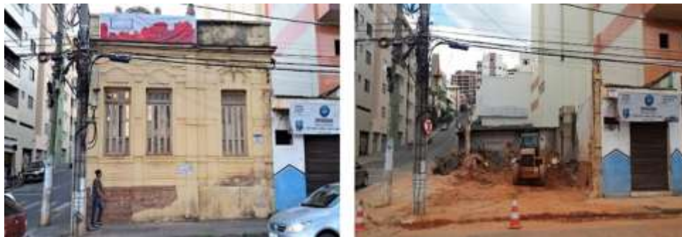
Figura 4 - Casa 320 (a) e demolição da Casa 320 (b)
