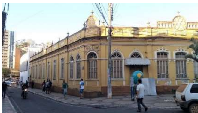
Figura 5 - Fachada em estilo eclético do Hotel Rubim no centro de Viçosa.
