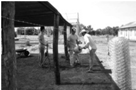
Figura 1 - Construção do viveiro
