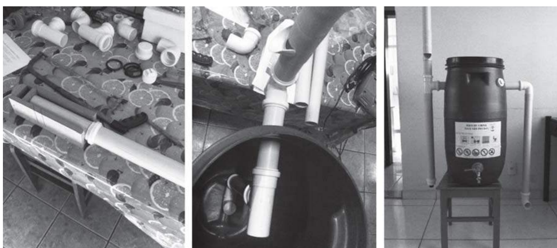
Figura 3 - Fotos da construção do protótipo de uma minicisterna. (a) Construção do filtro autolimpante; (b) Montagem do filtro autolimpante e redutor de turbulência. (c) Protótipo pronto da minicisterna com a sugestão de adesivo.
