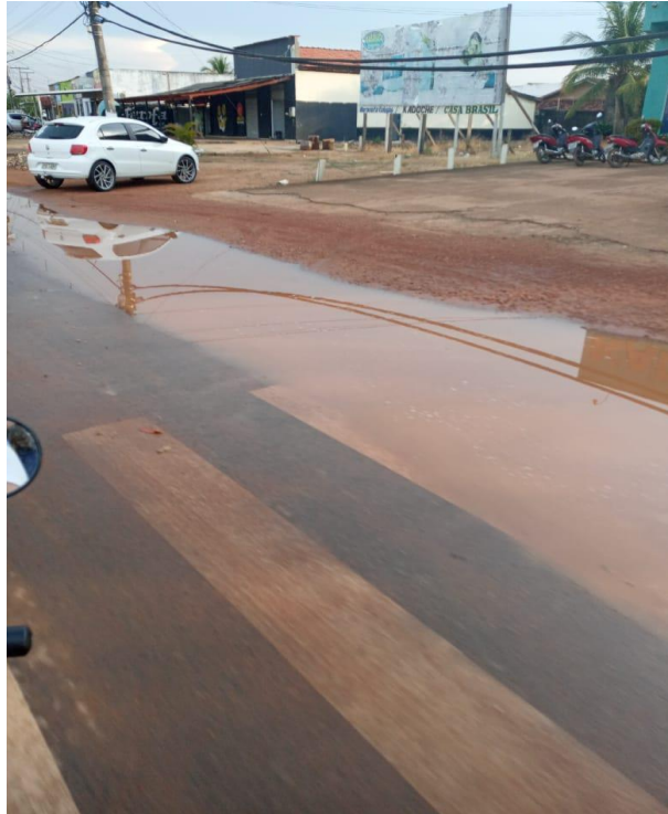
Figura 1 – Imagem da Avenida Raul Cláudio Prates no dia 05/10/2020.
