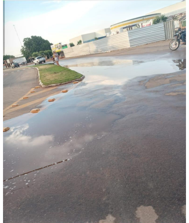
Figura 2 – Imagem da Avenida Raul Cláudio Prates no dia 06/10/2020.
