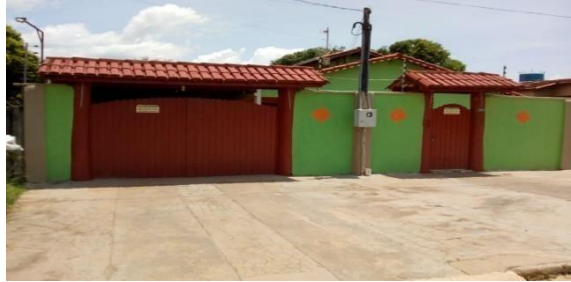
Figura 4 – Fachada externa da Casa 5.
