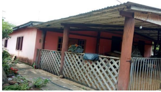
Figura 6 – Fachada, parte interna, Casa 7.
