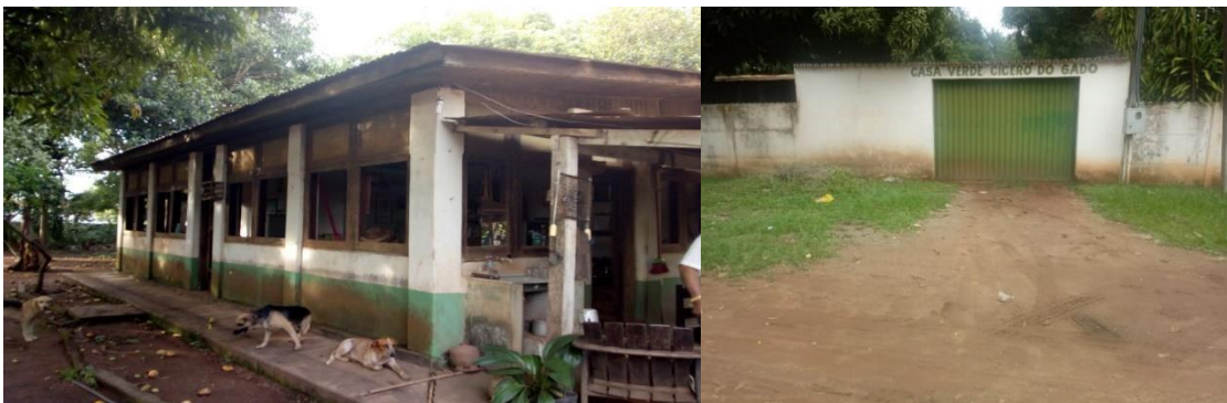
Figura 7 – Casa 8: lateral interna (à esquerda) e frente externa (à direita)
