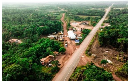
Figura 1 - Construção e pavimentação da Perna Leste, complexo Alça Viária. Fonte: Aguiar (2020).
