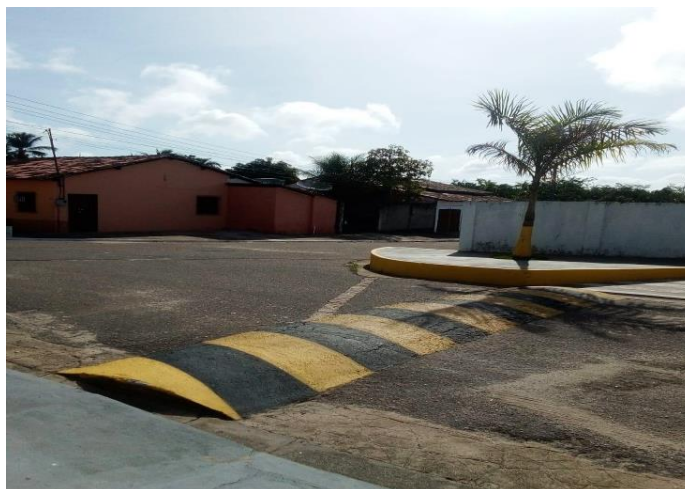
Figura 5 – Lombada com marcação em amarelo e preto.
