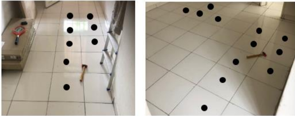
Figura 4 - Piso cerâmico com as marcações dos destacamentos.
