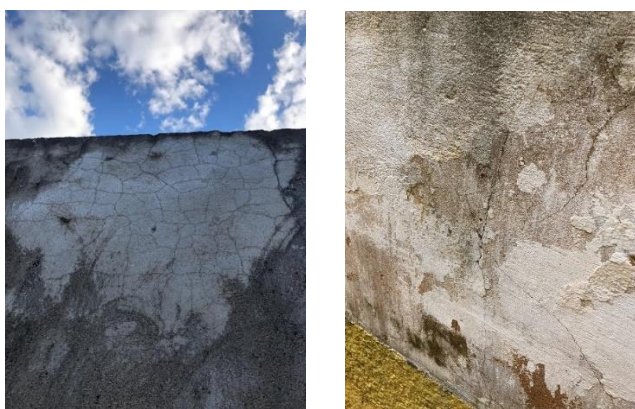
Figura 3 – Fissuras mapeadas.
