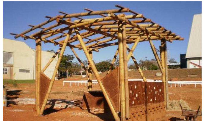
Figura 3 - Telhado construído de bambu. Fonte: Bambubrasileiro (2015).
