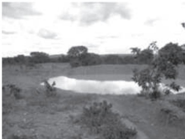
Figura 2 - Barraginha com água da chuva colhida e após infiltração no solo.
