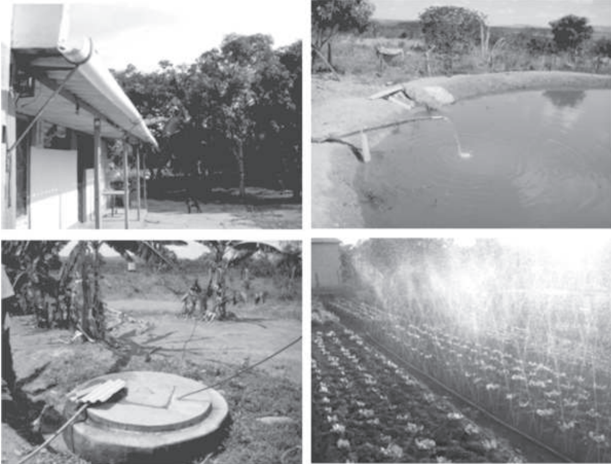
Figura 3 - Abastecimento e uso de água de chuva captada por telhado e Barraginhas e armazenada no Lago.
