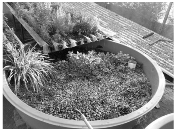
Figura 5 - Foto de filtro biológico de nível variável, com destaque da posição direita da parte interna do filtro, que mostra a imagem do sifão regulador de nível (Hundley, 2013).
