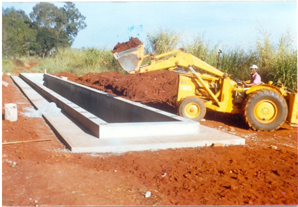
Figura 1. Retroescavadeira realizando operação de retorno do solo desestruturado à caixa de solo. Observa-se estrutura em alvenaria para recebimento do solo, protegendo-o contra possível contaminação.
