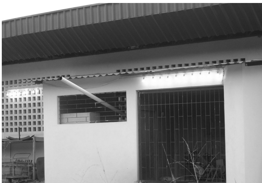
Figura 4. Vista geral da Estrutura montada para consumir a energia e acomodar o grupo gerador
