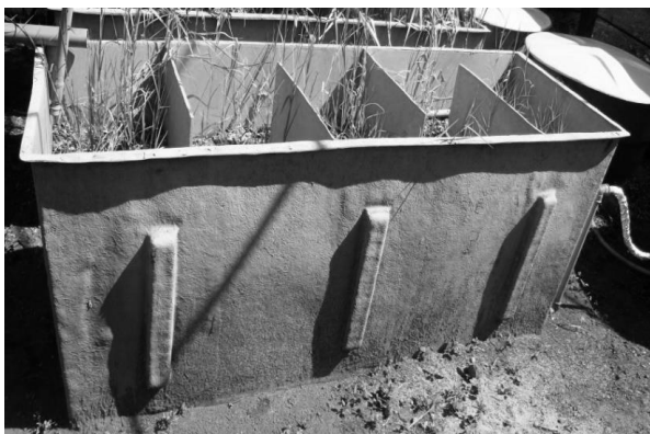
Figura 1. Diagrama esquemático e visão geral do sistema alagado construído chicanado utilizado no tratamento da água residuária da suinocultura.
