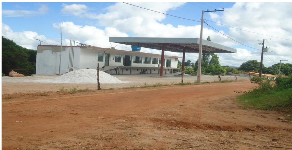
Figura 02 - Construção de auto posto de combustíveis no Agreste de Itabaiana/SE. Fonte: Trabalho de campo, junho de (2016).
