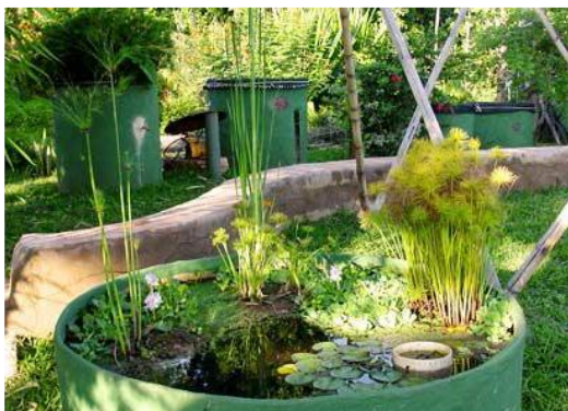
Figura 2: Filtros biológicos construídos em ferrocimento, baseados no processo de biorremediação e utilizados na permacultura para reuso de águas cinzas
